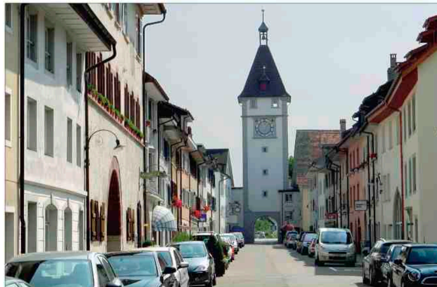
Der parkierte Verkehr im Zentrum von Neunkirch wird von vielen als Ärgernis empfunden. Es müssten Parkplätze ausserhalb der Kernzone entstehen.
